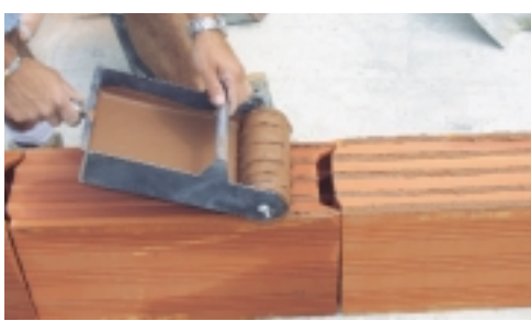
Dépose de mortier Joint Mince à l'aide du rouleau applicateur.
